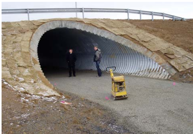
Mynd af undirgöngum svipuðum þeim sem verða lögð undir Suðurlandsveginn. Þessi göng liggja undir Suðurlandsveg við Norðlingaholt og eru einvörðungu fyrir gangandi vegfarendur. Reiðgöng verða eins í laginu, en 0,5 metrum hærrí (Ljósmynd Baldvín Einarsson, Línuhönnun)
