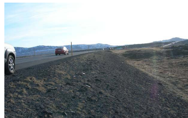
Umferð um Suðurlandsveginn við Litlu kaffistofuna
