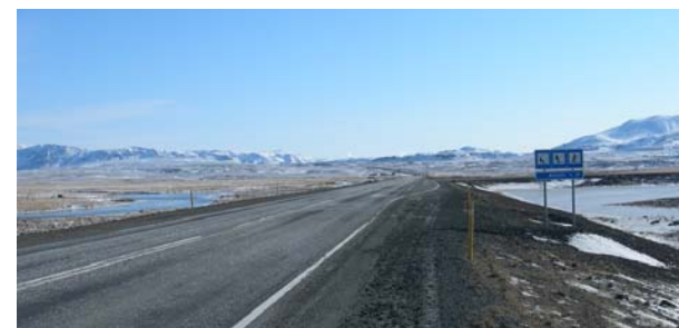
Mynd tekin til austurs yfir Suðurlandsveg við gatnamót að Bláfjöllum
