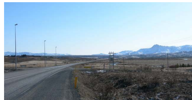
Séð yfir Suðurlandsveg frá gatnamótum við Hafravatnsveg í austurátt að Vífilsfelli
