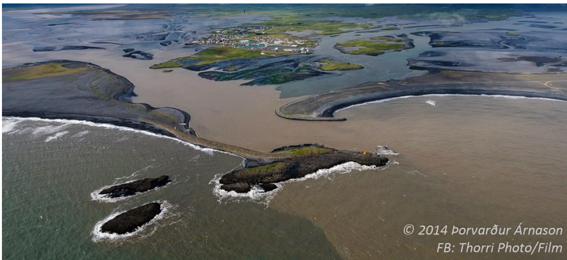
Mynd 80. Sjóvarnargarðar á Suðurfjörutanga og Austurfjörutanga sjást. Garðurinn á Suðurfjörutanga er 600 m langur. Garðurinn á Austurfjörutanga skiptist í 200 m langan sjóvarnargarð og 300 m langan leiðigarð.
