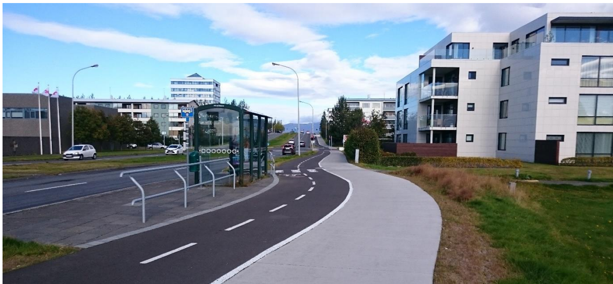
MYND 59 Hjólastígur liggur aftur fyrir biðstöð. Girðing, milli hjólastígs og biðstöðvar/bryggju, stýrir hvar gengið er yfir hjólastíginn.
