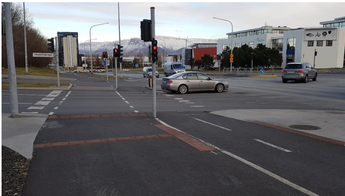
MYND 39 Ljósagatnamót með sér ljós ætluð hjólreiðamönnum og sér ljós ætluð gangandi. Háleitisbraut, Reykjavík.
