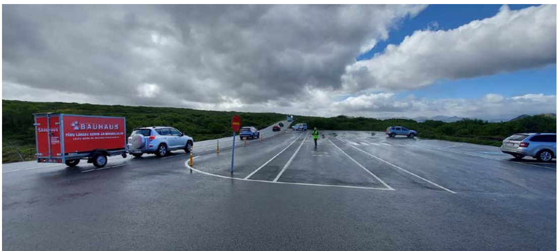
Mynd 4.13 Áningarstaður við Hrafnagjá séð úr vestri. Þingvallavegur liggur meðfram áningarstaðnum vinstra megin.
