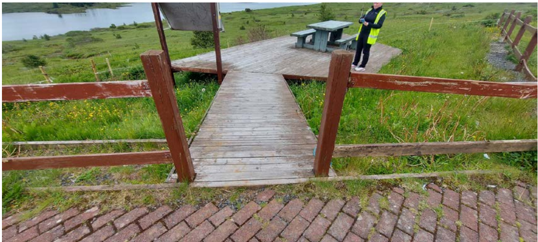
Mynd 4.48 Útsýnispallur við áningarstaðinn er orðinn lúinn og slyshætta ef gestir stíga fram af brún hans.
