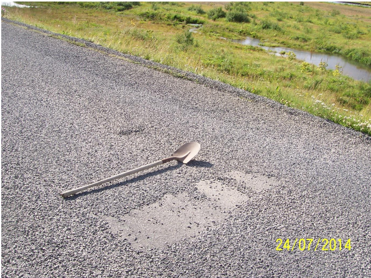
Mynd 25 Dæmigerða skemmd á 1-m 3 vegna verklags eða tækjabúnaðar
