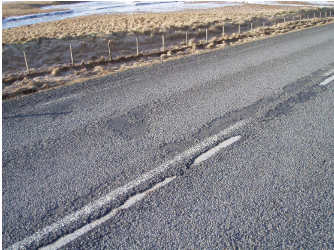
Klæðing með bikpeytu 2005, Hringvegur í Leirársveit 1-g3, 3. mars 2006 Heimreið að Læk – að útihúsum, um 180-360 m: Skemmd á vinstri akrein
