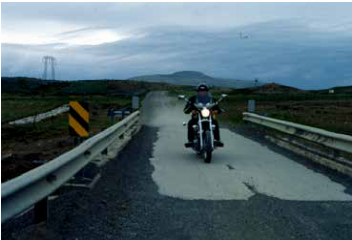
Varasöm brú, lausamöl og steypd brúargólf.
