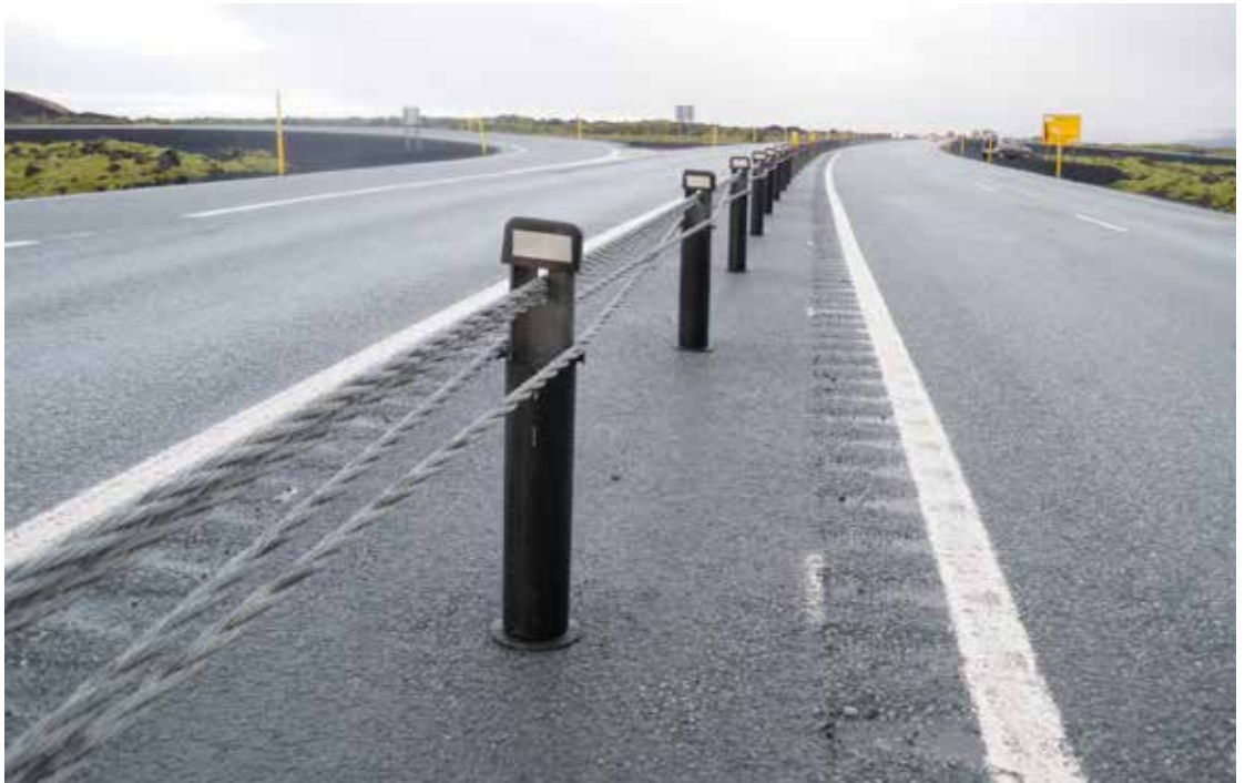
Plasthólkar á stólpa – tilraunaverkefni Vegagerðarinnar við Þrengslavegamót.
