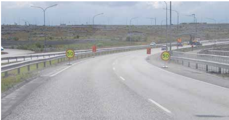
Skilti í vegbrún vara við hættu en geta líka skapað hættu.
