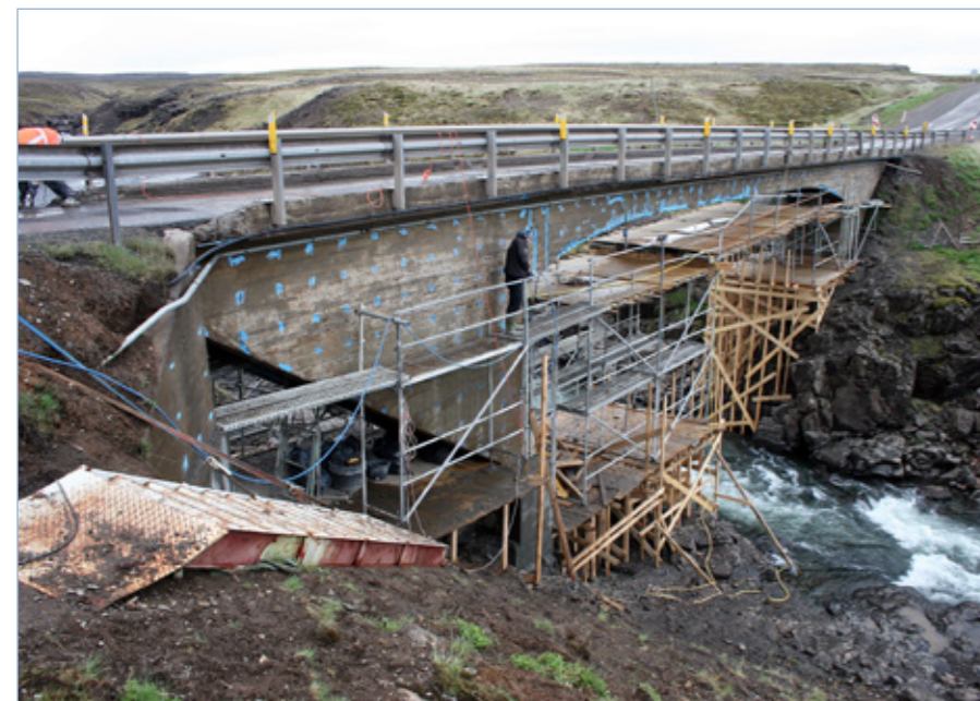
Sæfellsnesvegur (54) um Skógarströnd, viðgerð á brú yfir Bakká 1. júní 2017.
