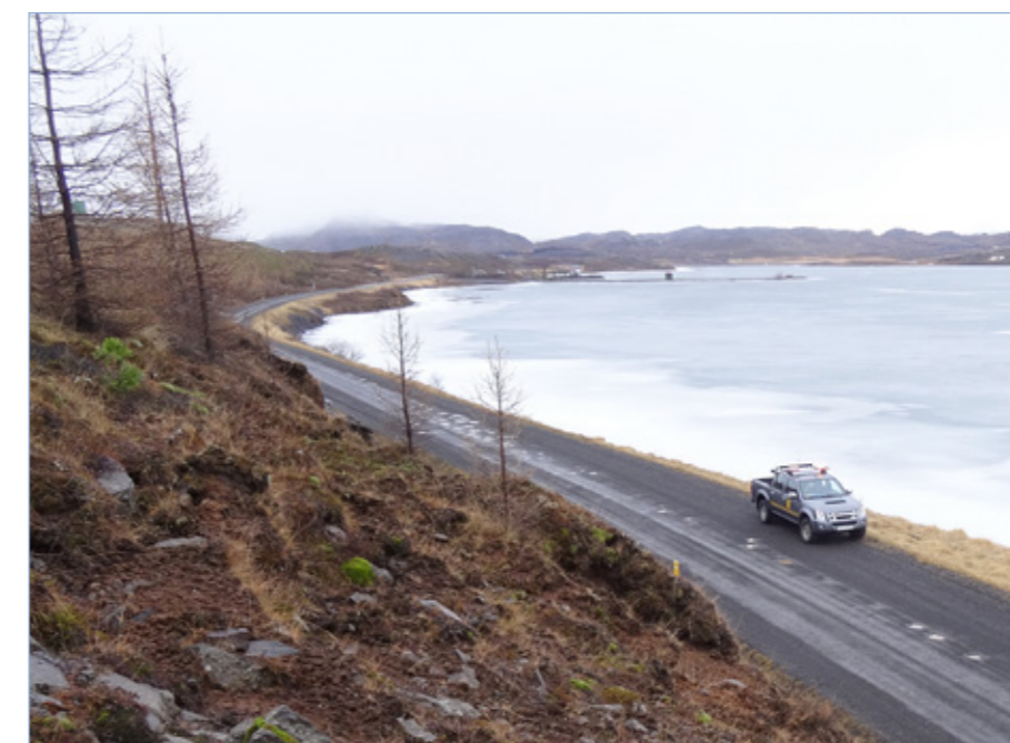
Hróarstunguvegur (925) um Urriðavatn. Undirbúningur framkvæmda, 16. febrúar 2017.
