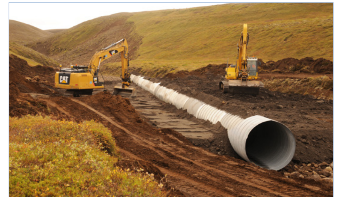
Dettifossvegur (862), ræsi sett niður, 13. september 2017.
