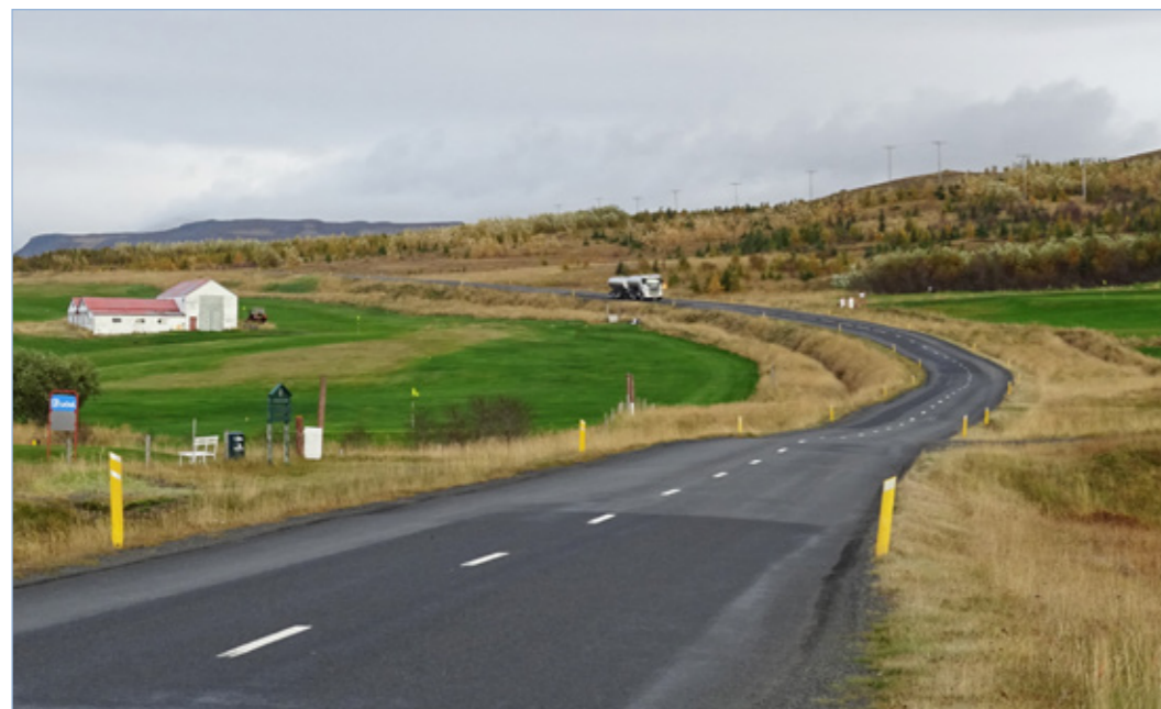
Skagastrandarvegur (74) Hringvegur – Þverárfjallsvegur, 2017. Verið er að undirbúa og hanna nýjan veg í stað núverandi vegar.
