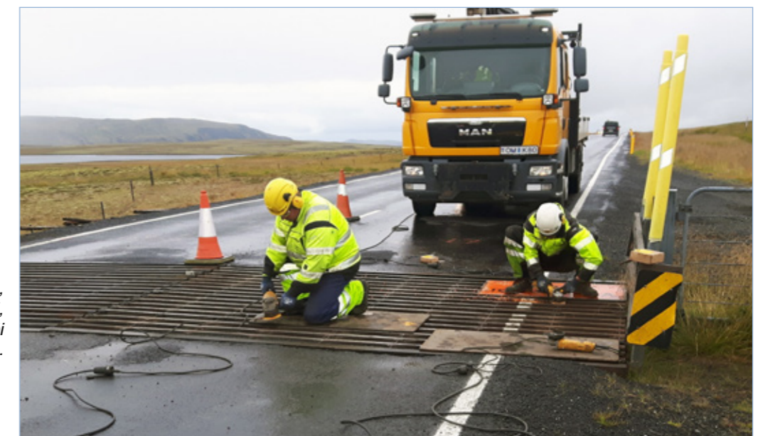
Þingvallavegur (36), skammt frá Skálafellsvegi, lagfæring á ristarliði 31. ágúst 2017.
