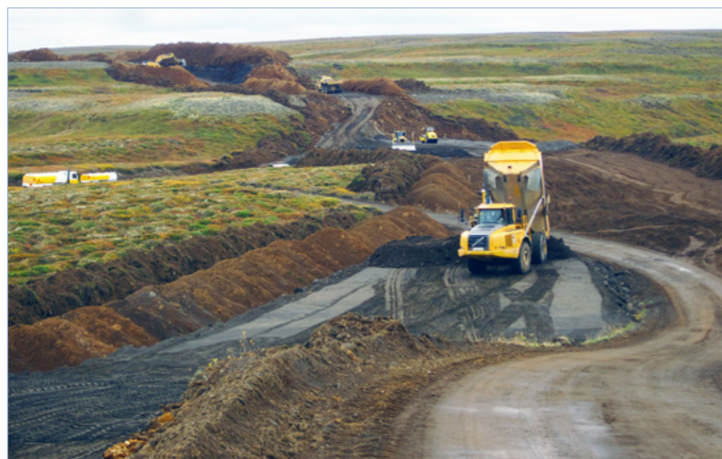
Dettifossvegur (862), 19. september 2017. Endurheimt staðargróðurs við vegagerð. Svarðlagi er ýtt upp í hrauka sitthvoru megin við vegstæðið. Eftir að vegurinn hefur verið byggður er þessu svarðlagi ýtt upp í vegfláann að nýju og ef allt fer að óskum grær fláinn upp með staðargróðri.
