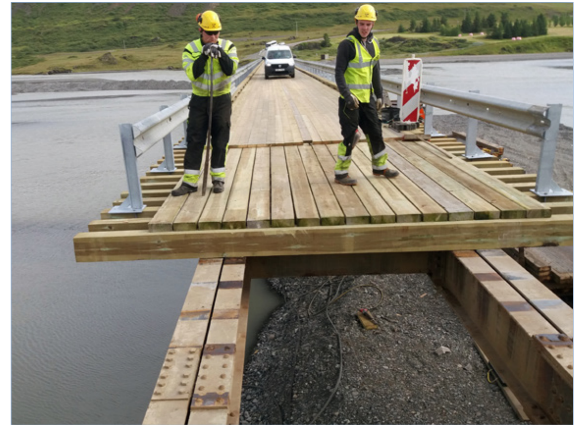
Hringvegur (1), Jökulsá í Lóni, endurnýjun brúargólfs 18. júlí 2017.
