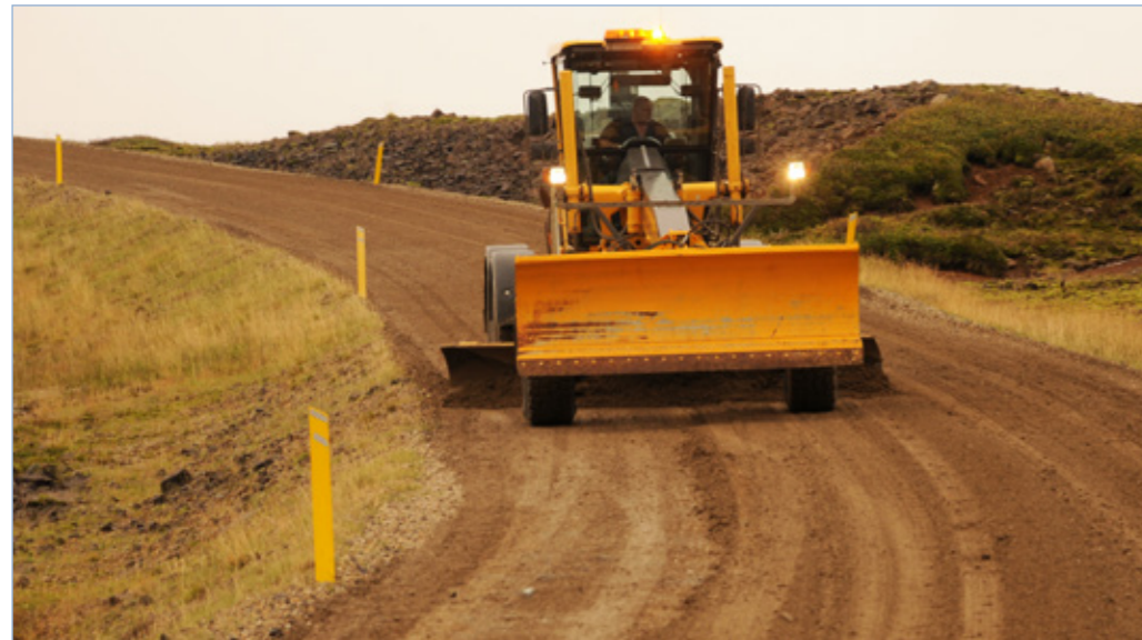
Borgarfjarðarvegur (94) á Vatnsskarði, vegheflun 13. september 2017.
