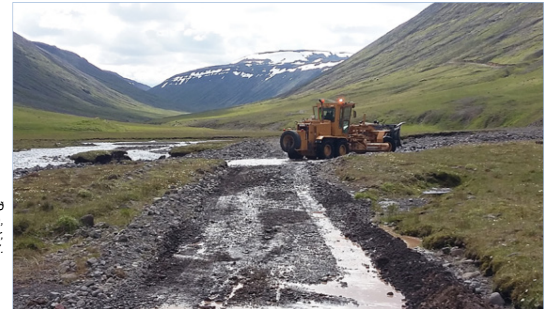
Eyjafjarðarleið (F821), lagfæringar, 29. júní 2017.
