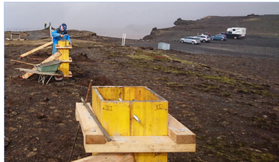
Afmörkun á lóð Dyrhólaeyjarvita með steiptum stöplum 6. apríl 2017.
