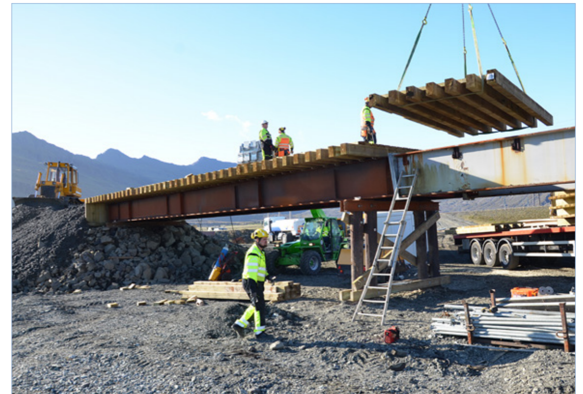
Hringvegur (1), Steinavötn, gerð bráðabirgðabrúar 2. október 2017.
