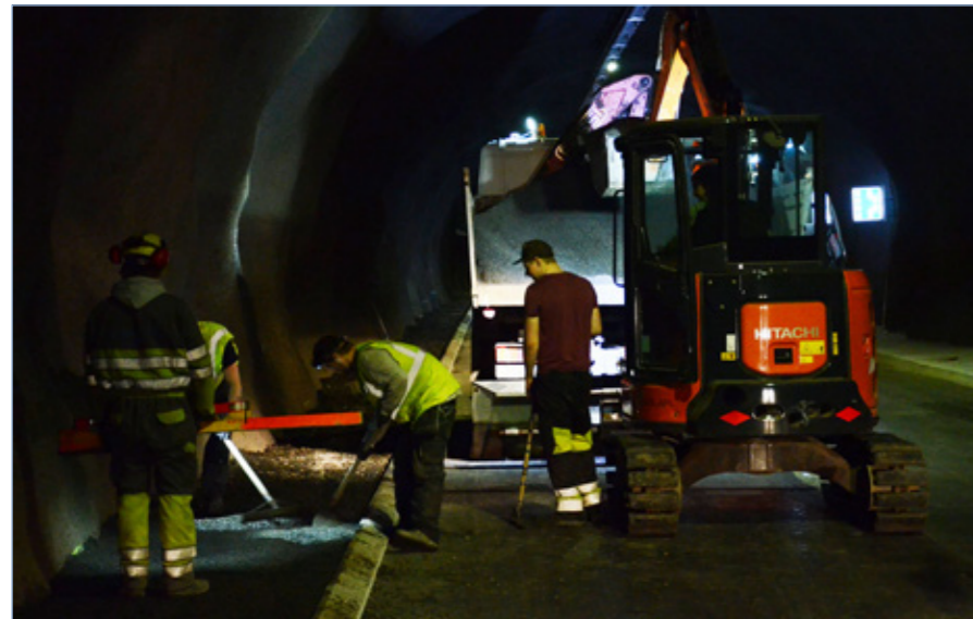
Norðfjarðargöng, vinna við vegöxl, 20. september 2017.
