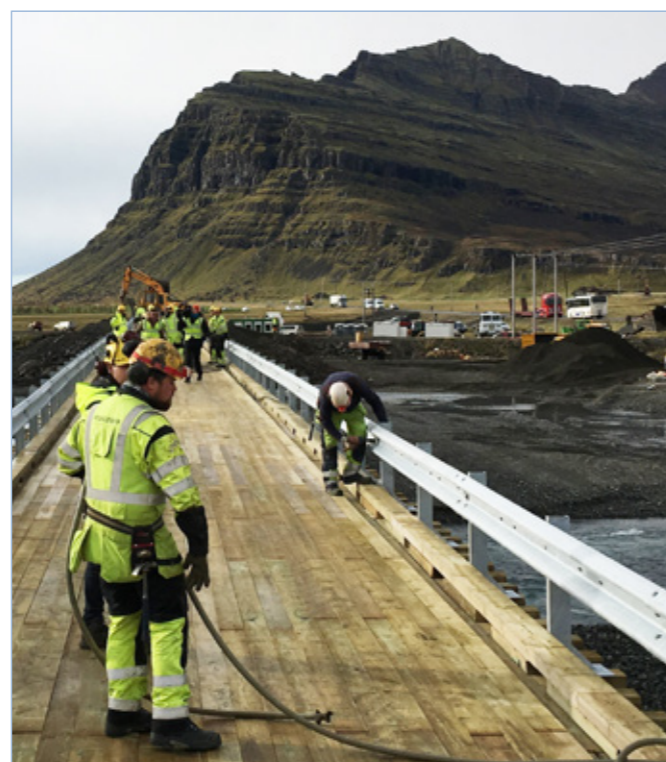
Hringvegur (1), Steinavötn, 4. október 2017. Síðustu handtökin við gerð bráðabirgðabrúar.
