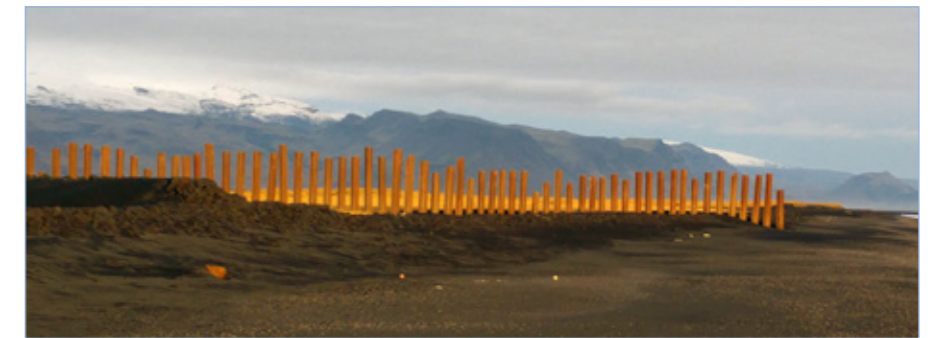
Landeyjahöfn, byggður var skjólveggur úr 63 stálþilspilötum austan við höfnina til að minnka sandfok í innri höfnina. 21. október 2017.
