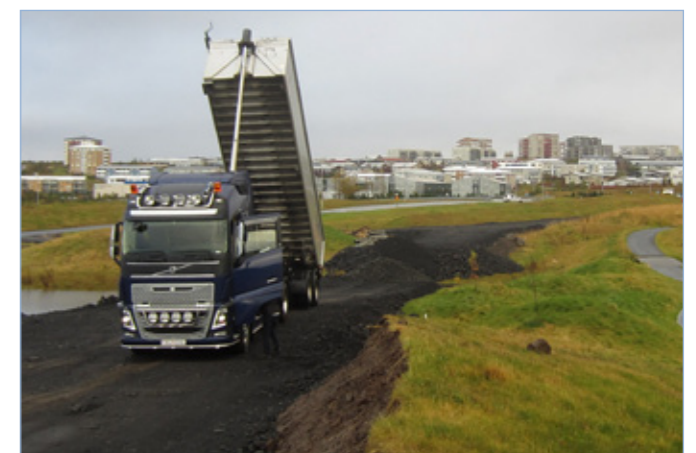
Arnarnesvegur (511), framkvæmdir, 9. október 2015.
