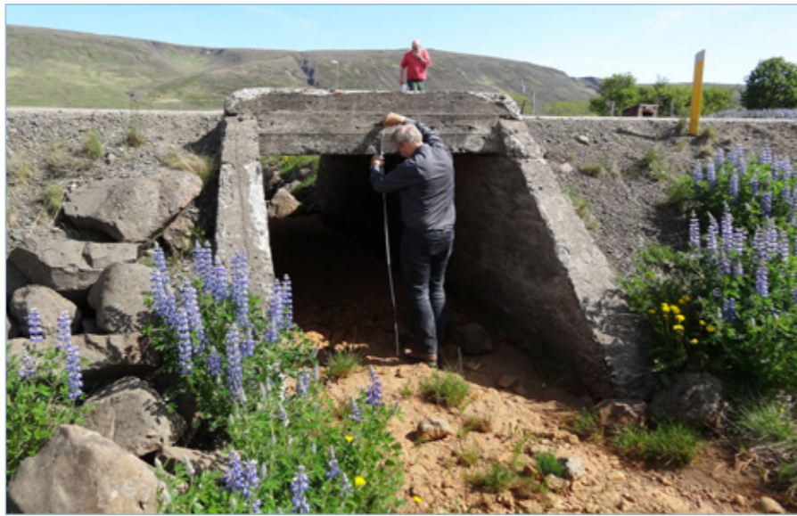
Uxahryggjavegur (52), Skarð - Brautartunga. Stærð ræsa mæld fyrir hönnun nýs vegar, 26. júní 2015.
