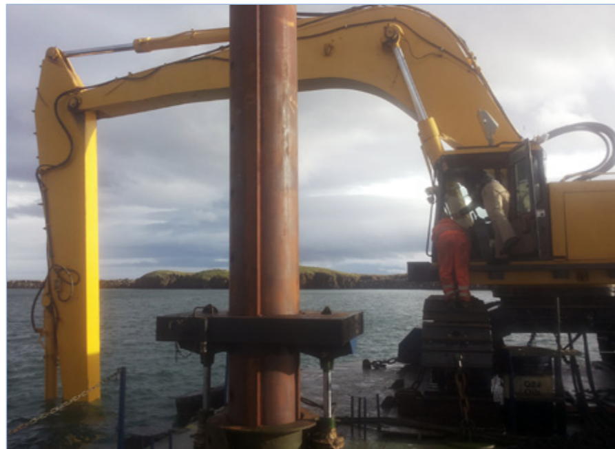
Vopnafjörður, dýpkunarframkvæmdir, 6. október 2015.
