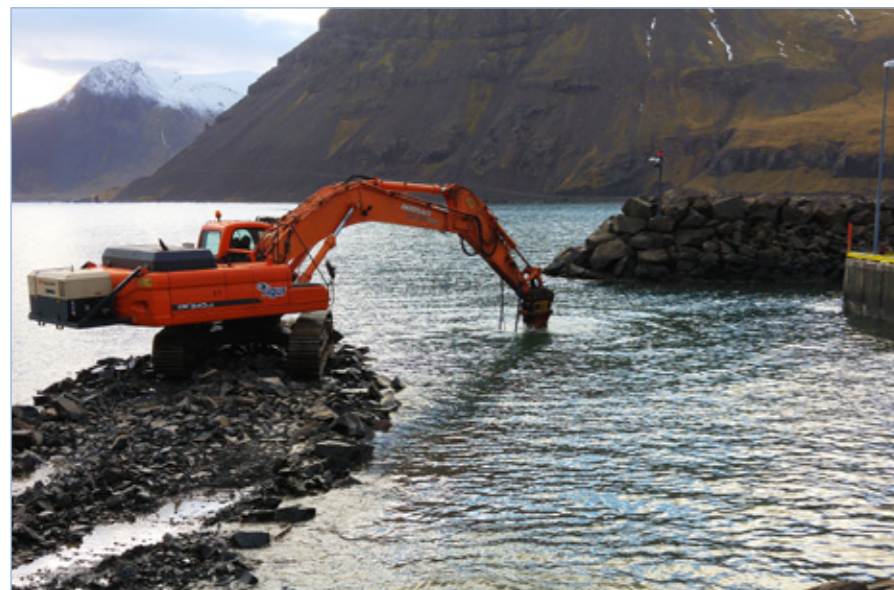
Norðurfjörður, dýpkunarframkvæmdir, 10. nóvember 2015.
