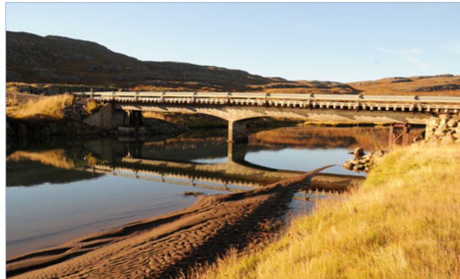
Strandavegur (643), brú á Bjarnarfjarðará, 28. september 2016. Ný brú verður byggð í framhaldi nýs vegar yfir Bjarnarfjarðarháls.
