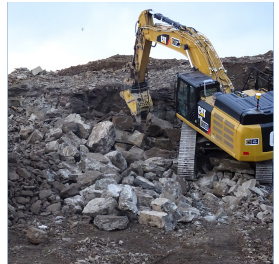
Bakkavegur Húsavík, jarðgöng í Húsavíkurhöfða, unnið við forskeringu 23. nóvember 2015.
