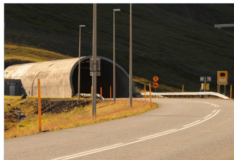
Siglufljarðarvegur (76) Héðinsfjarðargöng, gangamunni í Siglufljóði, 18. ágúst 2015.
