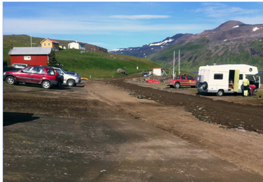
Strandavegur (643) um Djúpvík, framkvæmdir, 19. ágúst 2015.
