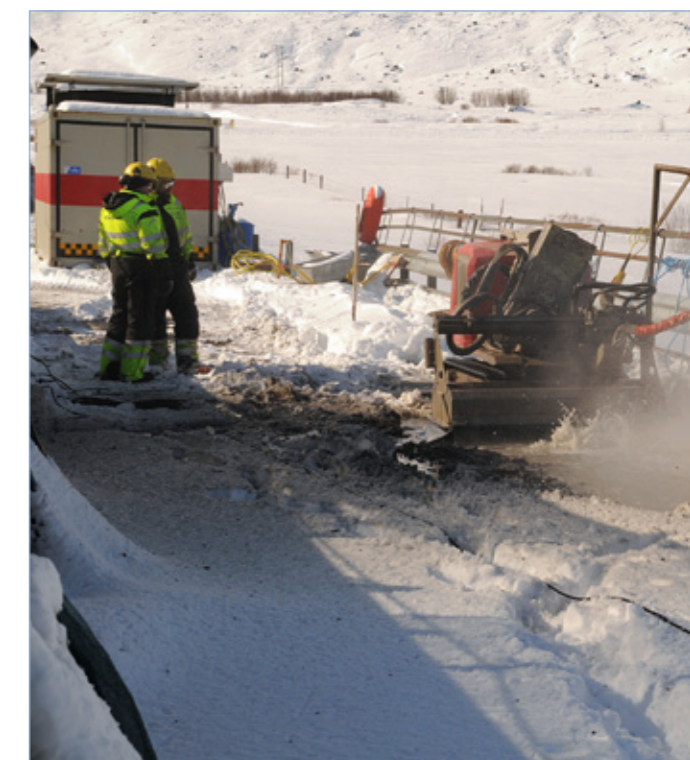
Endurnýjun á slitgólfi Sogsbrúar hjá Þrastarlundi, 30. mars 2015.
