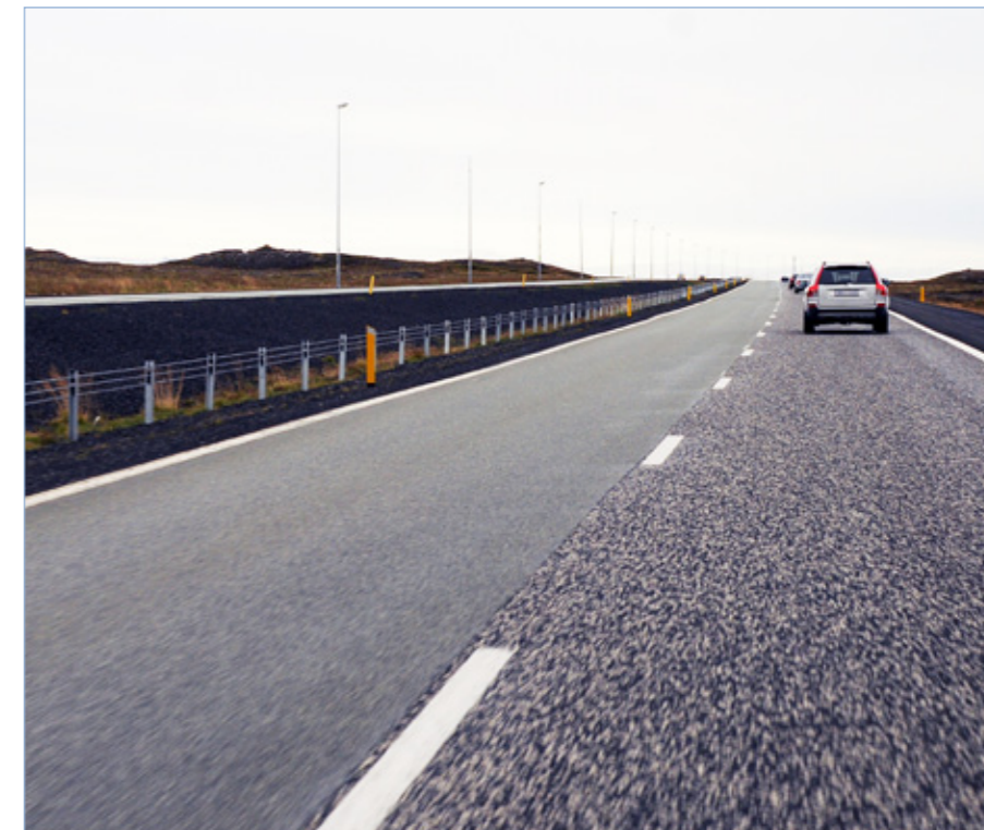
Reykjanesbraut (41), víravegríð aðskilur umferðarstrauma, 3. október 2015.
