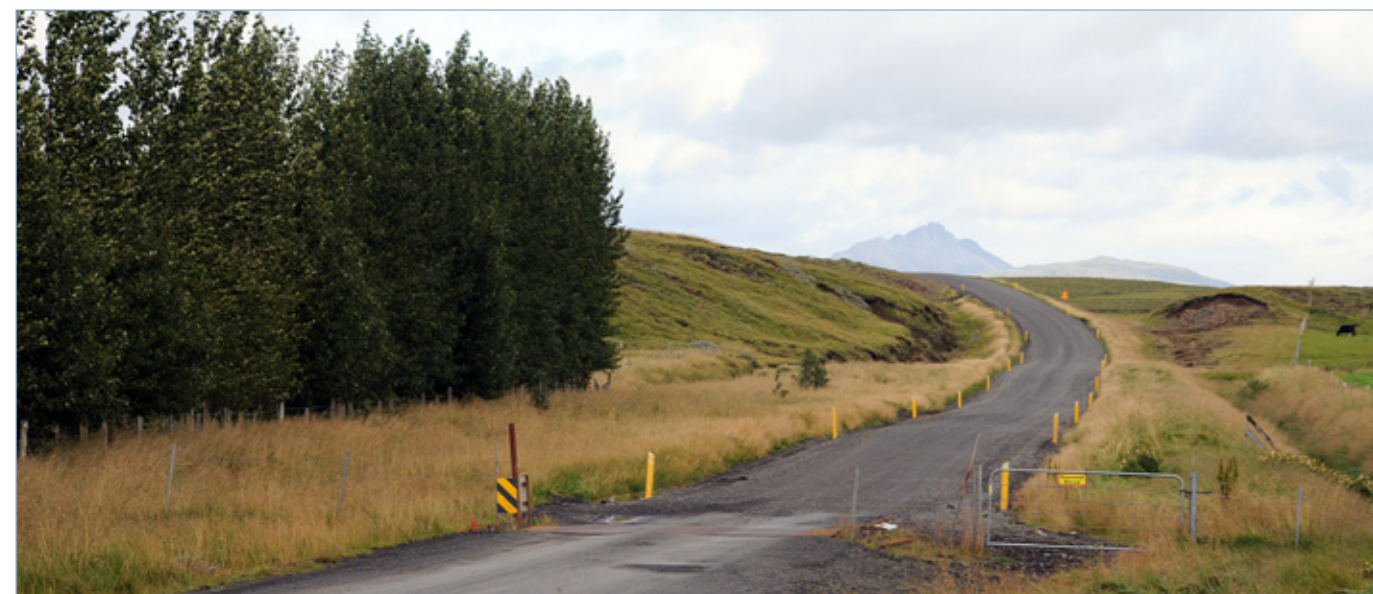
Reykjavegur 355-01, Biskupstungnabraut – Laugarvatnsvegur. Unnið hefur verið að hönnun og undirbúningi.
