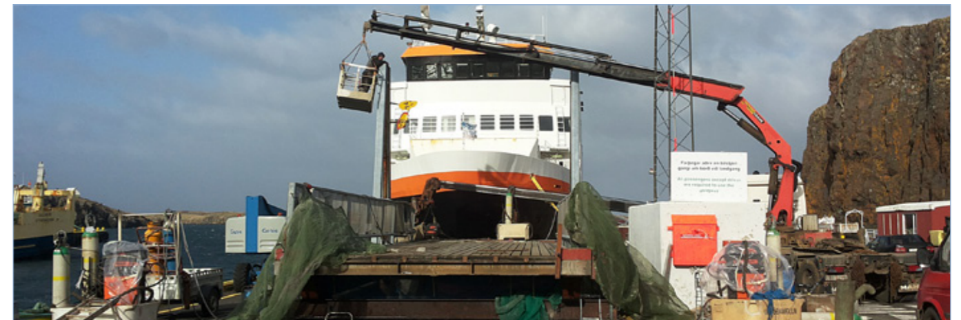
Ný Breiðafjarðarferja Baldur í Stykkishólsmhöfn. Unnið að endurbótum ferjubryggju, 22. apríl 2015.
