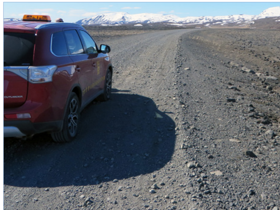
Kaldadalsvegur (550) fyrir framkvæmdir, 1. júní 2015.
