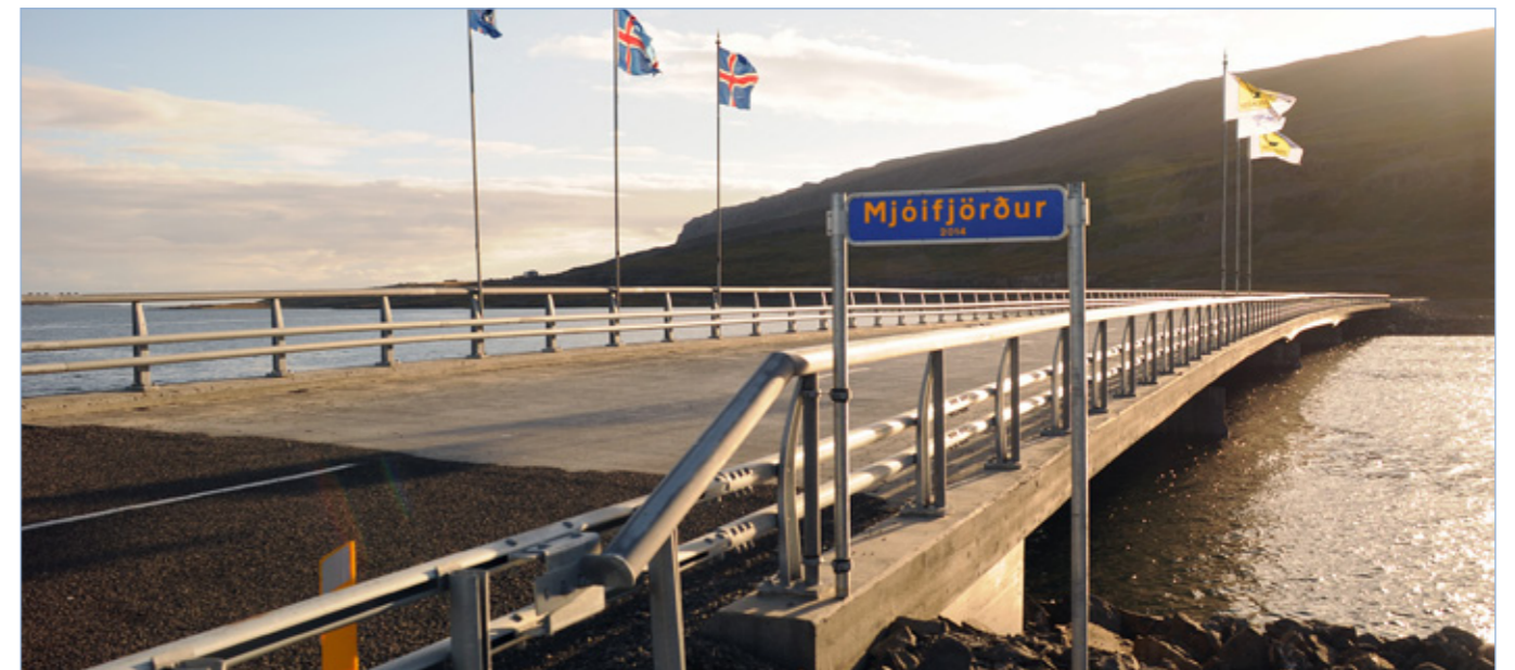
Vestfjarðavegur (60), brú á Mjóafirði á vígsludegi 11. september 2015.
