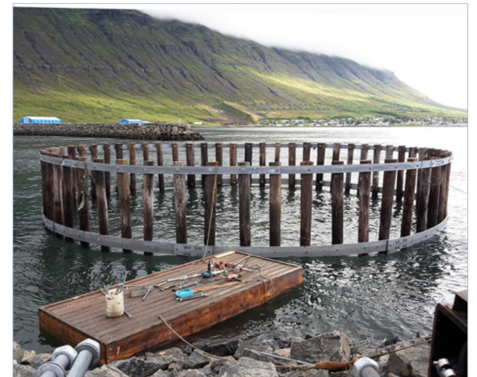
Neskaupstaður, gerð tunnu á enda grjótvarnargarðs, 15. september 2015.
