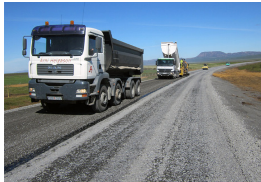
Dettifossvegur (862). Neðra lag klæðingar lagt 26. júní 2015.
