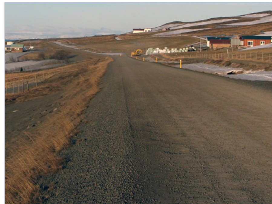
Vatnsnesvegur (711) norðan við Hvammstanga, fyrir framkvæmdir, 31. janúar 2013.
