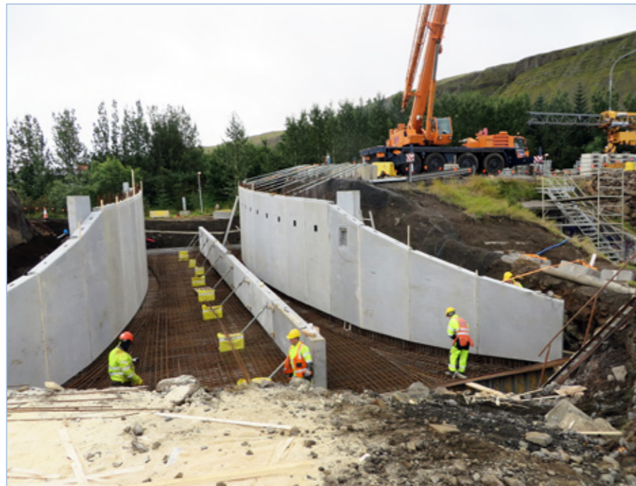
Hringvegur (1), undirgöng við Aðaltún í Mosfellsbæ, 2. september 2015.
