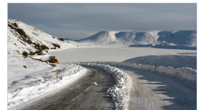
Krýsuvíkurvegur (42) við Kleifarvatn, 3. mars 2015.
