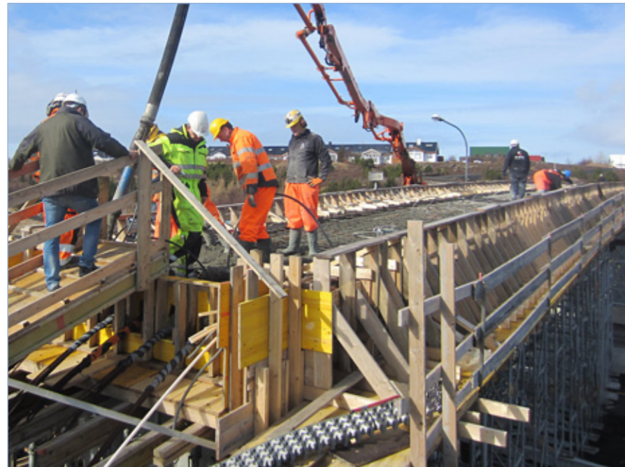
Gerð göngubrúar yfir Breiðholtsbraut, 15. apríl 2015.
