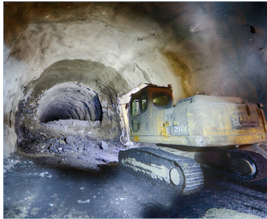
Norðfjarðargöng eftir síðustu sprengingu 17. september 2015.
