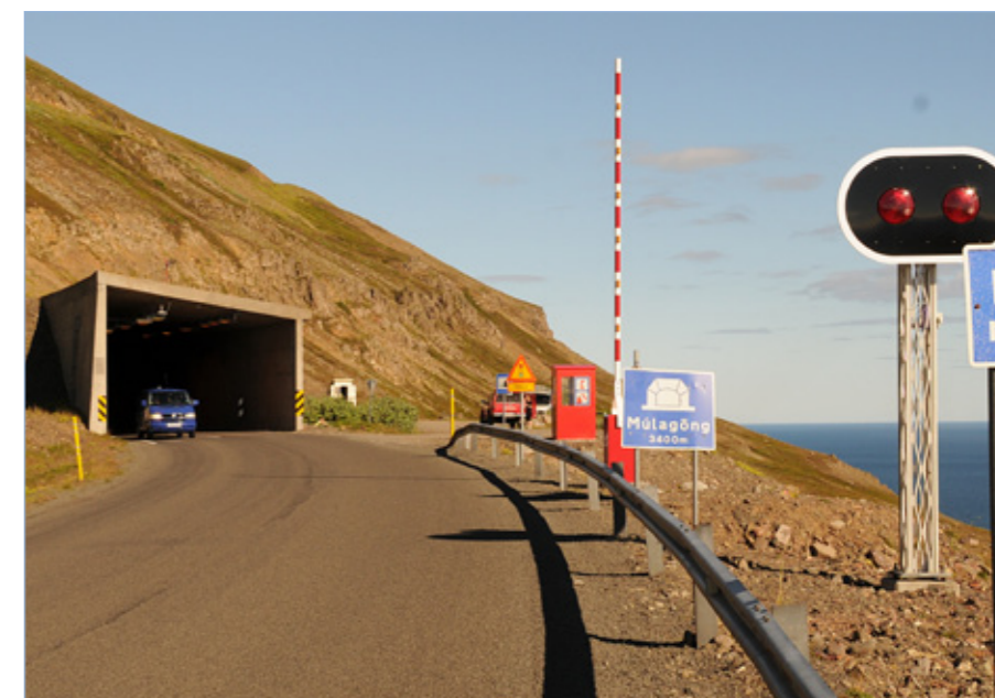
Siglufljarðarvegur (76) Múlagöng, gangamunni að suðvestan, 18. ágúst 2015.
