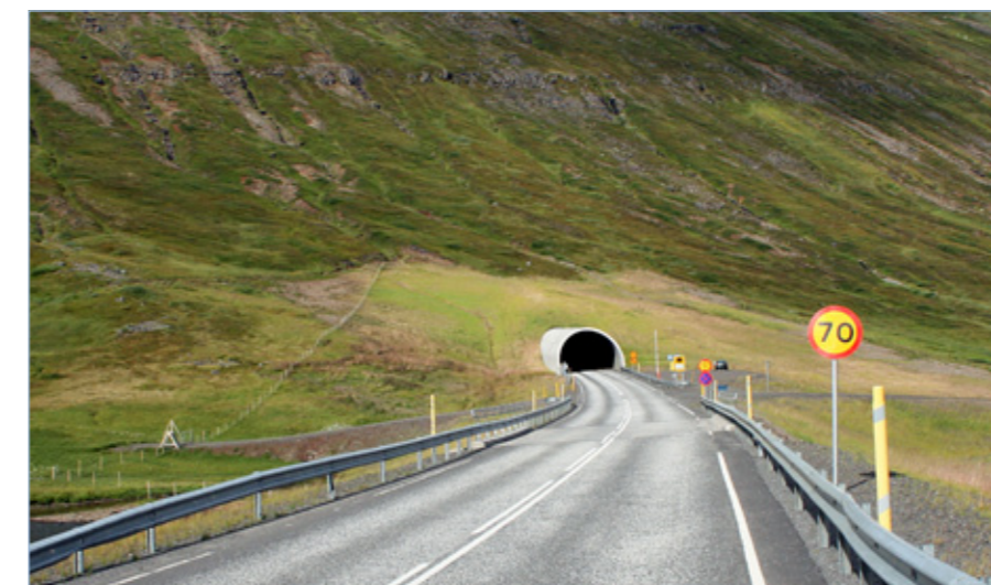
Siglufjarðarvegur (76), Héðinsfjarðargöng, gangamunni í Héðinsfirði, 28. ágúst 2013.
