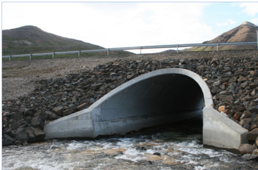
Borgarfjarðarvegur (94) um Njarðvíkurá, 14. ágúst 2013.
