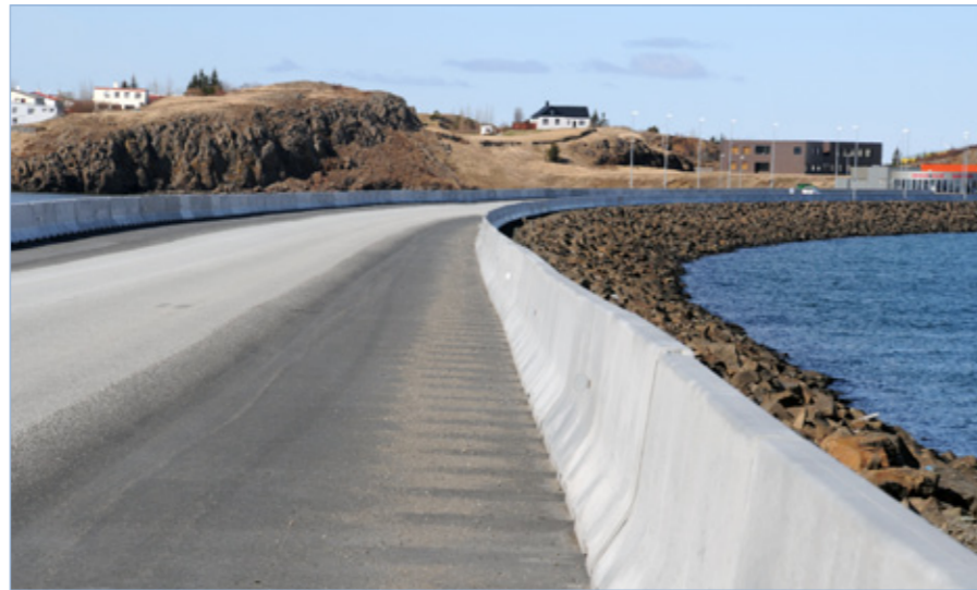
Hringvegur (1) um Borgarfjarðarbrú, vegrið og endurröðuð grjótvörn.
