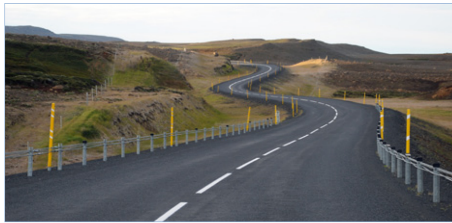
Norðausturvegur (85), Hófaskarðsleið, 29. ágúst 2013.
