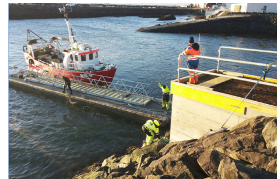
Reykhólar, vinna við flotbryggju, 8. nóvember 2013.
