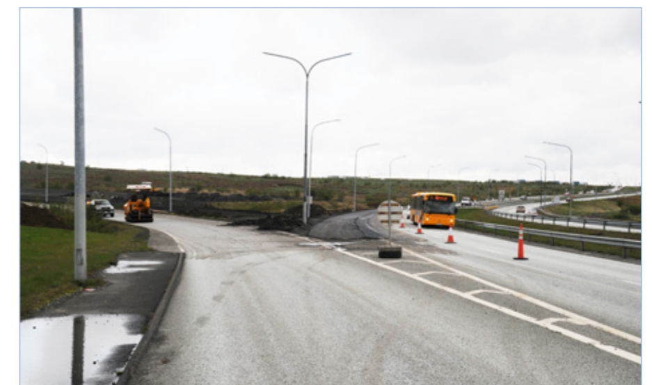
Hafnarfjarðarvegur (40) aðreina frá Fífuhvamsvegi, 5. júní 2013.
