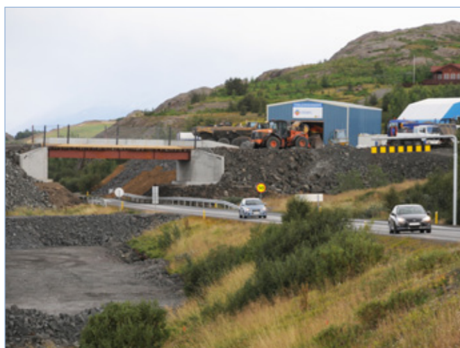
Vaðlaheiðargöng, bráðabirgðabrá fyrir vinnuumferð yfir Hringveg (1), 31. ágúst 2013.
