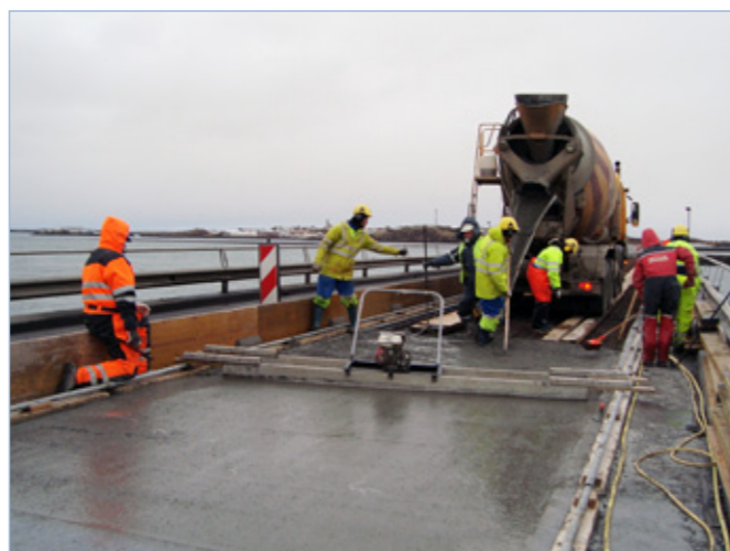
Borgarfjarðarbrú, nýtt slitlag steipt á hluta brúarinnar 30. október 2013.
