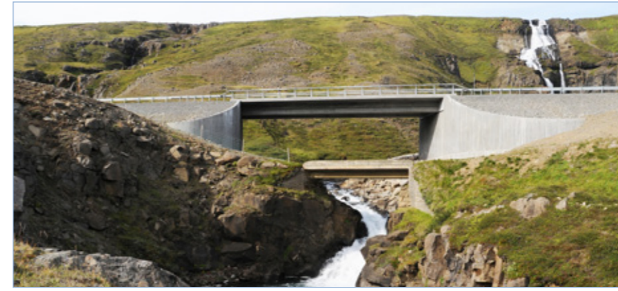
Hringvegur (1) í Jökuldal, ný brú á Ystu Rjúkandi, 29. ágúst 2013.
