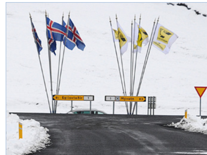
Norðausturvegur (85), vegamót við Hringveg (1) hjá Hárekstaðaleið, vígsludagur 23. október 2013.
