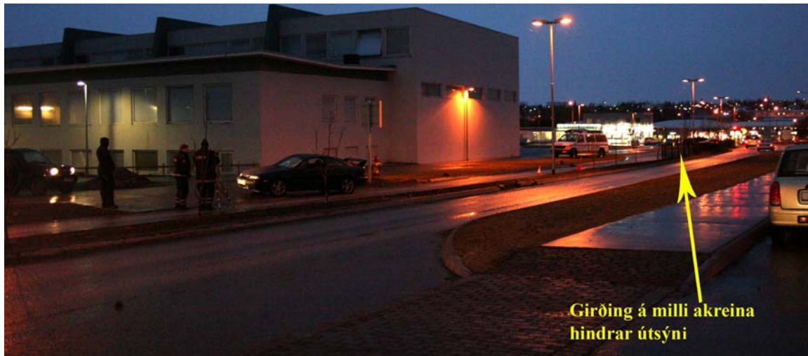
Mynd 11: Örin á myndinni bendir á sams konar grindverk og sjá má á mynd 10. Girðingar milli akreina geta hindrað útsýni.
