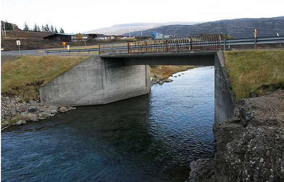
Mynd 2. Núverandi brú á Pennu á Barðastrandavegi (Peningsdalsá) (Heimild: Veggangakerfi Vegagerðarinnar)
