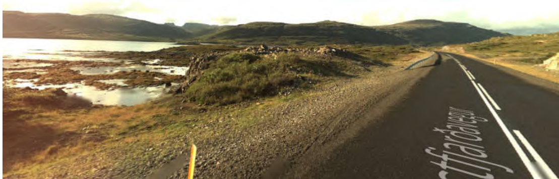
Mynd 2. Ljósmynd frá núverandi Vestfjarðarvegi þar sem ný veglína fer af núverandi Vestfjarðavegi í Vatnsfirði yfir í nýtt vegstæði (Heimilid www.ja.is )
