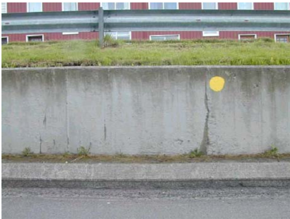
Mynd 12. Ósprunginn veggur, nærmynd sýnir staðsetningu á mælisniðum.
