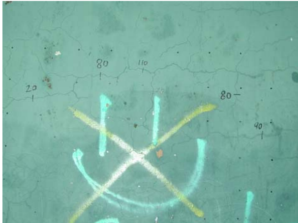
Mynd 22. Yfirborðssprungur í steypu. Mæling á sprungudýpt, tölurnar sýna hve djúpt sprungurnar ná inn í vegginn, í mm.
