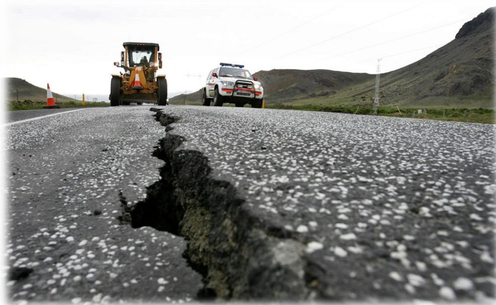
Sprungu í Suðurlandsvegi eftir jarðskjálfta árið 2008 (aldarafmaeli.hi.is).
