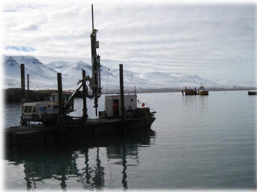
Unnið að dýpkun í Vopnafjarðarhöfn.
