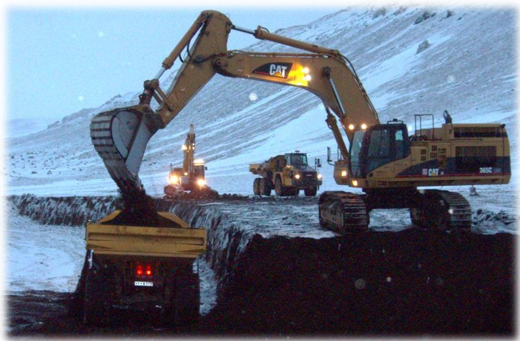
Vegavinna, Norðausturvegur (85) um Hófaskarð (RJ).
