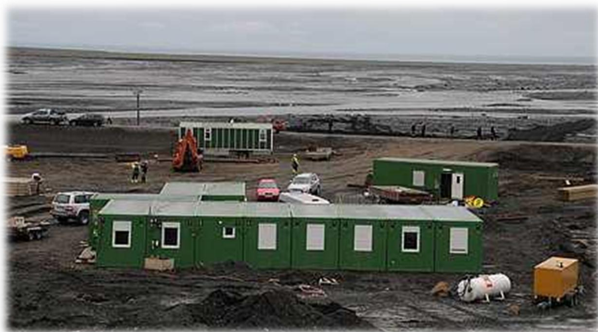
Bygging bráðabirgðabráúar yfir Múlakvísl (VAI).
