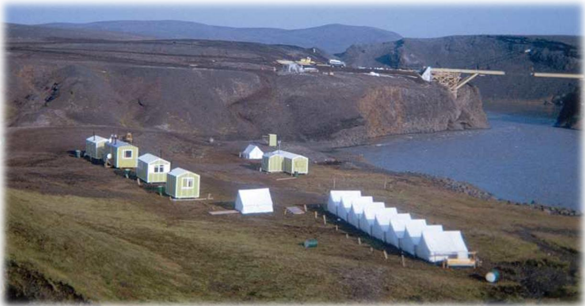
Bygging brúar yfir Tungnaá við Sigöldu (VAI).
