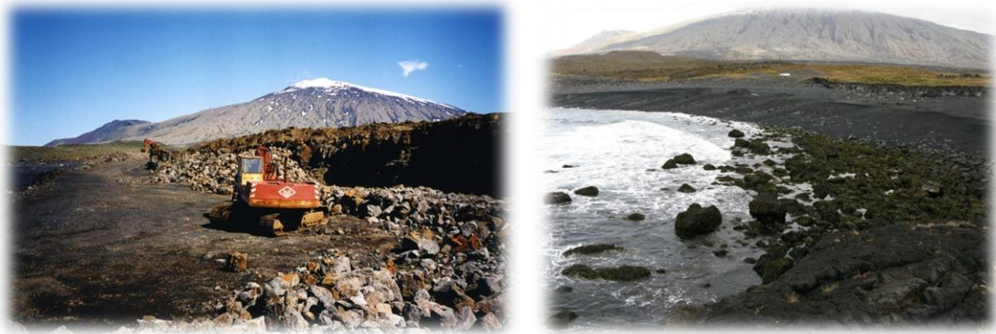
Náma í malarriði á Snæfellsnesi meðan á vinnslu stóð t.v. og að loknum frágangi t.h. (BS).
