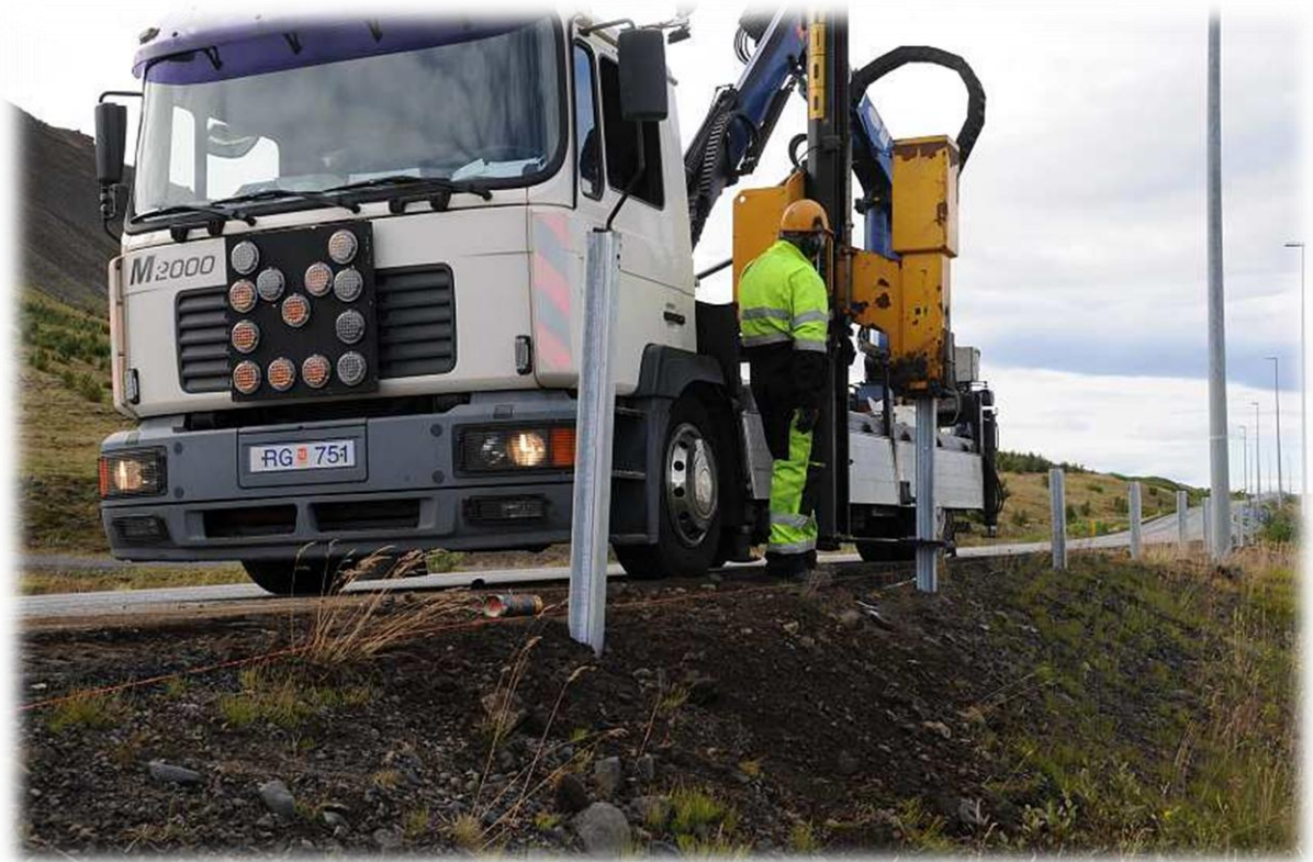
Verktaki setur niður vegrið við Þingvallaveg í Mosfellsdal (VAI).
