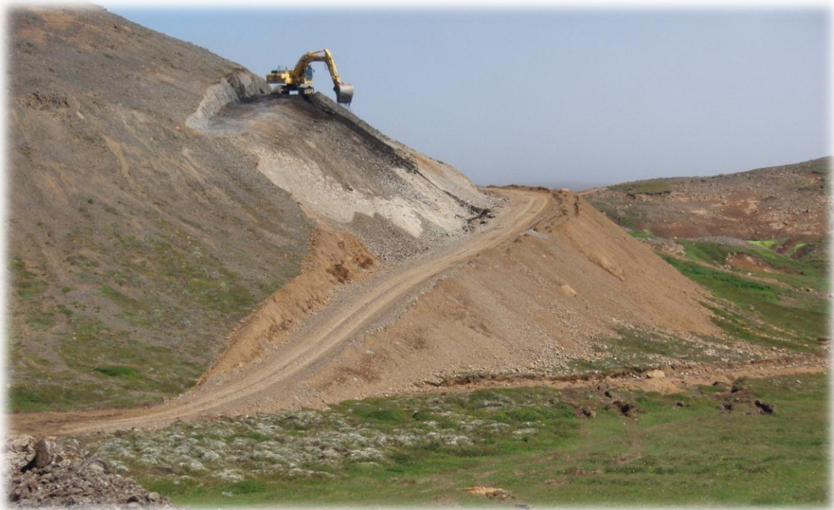
Unnið við vegagerð í Hófaskarði (RJ).
