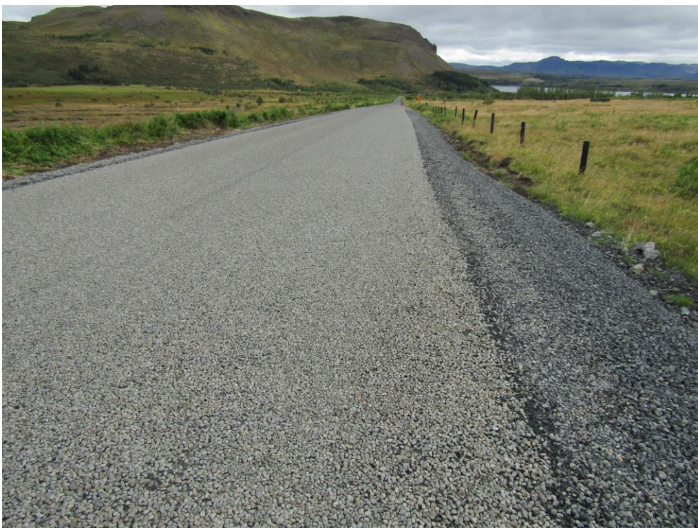
Mynd 14: Fortilraunarkafllinn eftir að klæðing var lagt yfir hann
