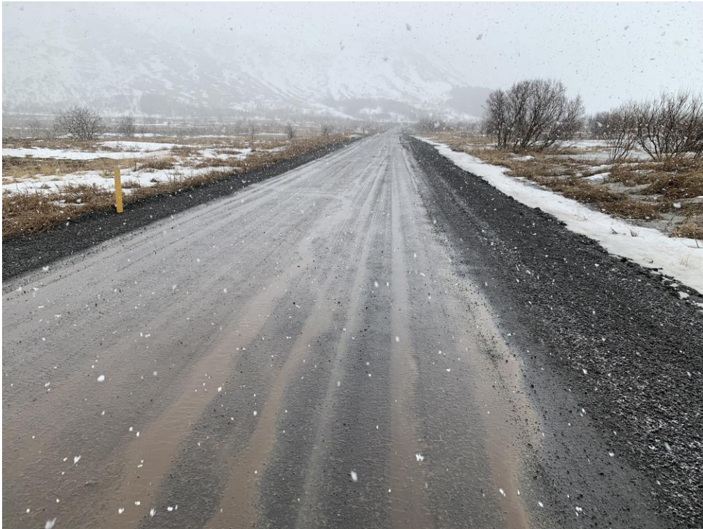
Mynd 27: Þriðji dagur framkvæmdar í mars 2020.
