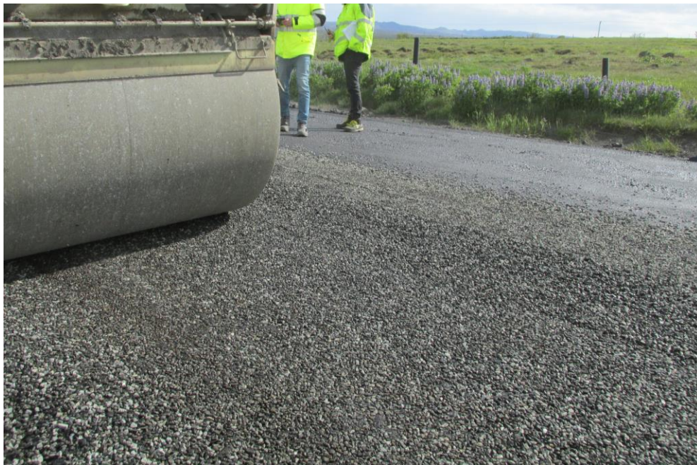
Mynd 5: Framkvæmd tilraunar á Hafravatni. Þjöppun steinefna með valtara
