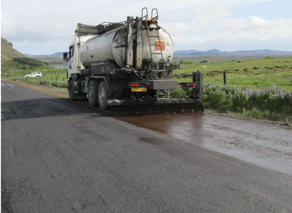
Mynd 4: Framkvæmd tilraunar á Hafravatni. Bikþeytu sprautað á veginn.
