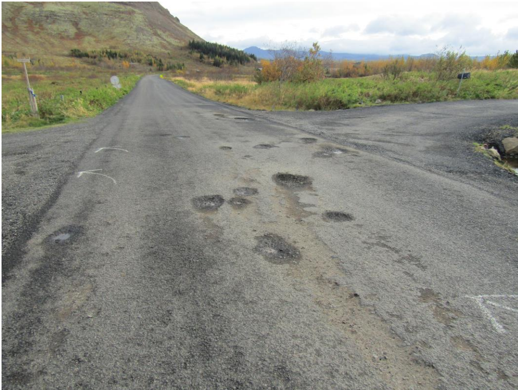
Mynd 20: Mesti álagsstaður tilraunakafans, þær holur sem höfðu myndast í október 2019.
