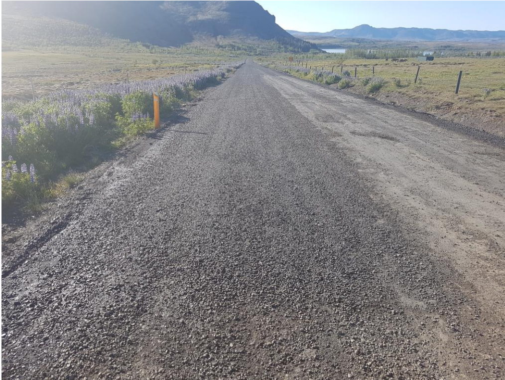
Mynd 13: Fortilraunar kaflinn nokkrum dögum eftir útlögn, aðeins var lagt klæðingarefni yfir vinstri helming vegarins.
