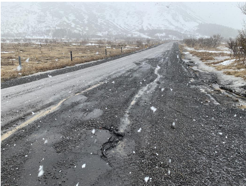
Mynd 29: Skemmd útrá holufyllingu á mesta álagsstaðnum mars 2020.
