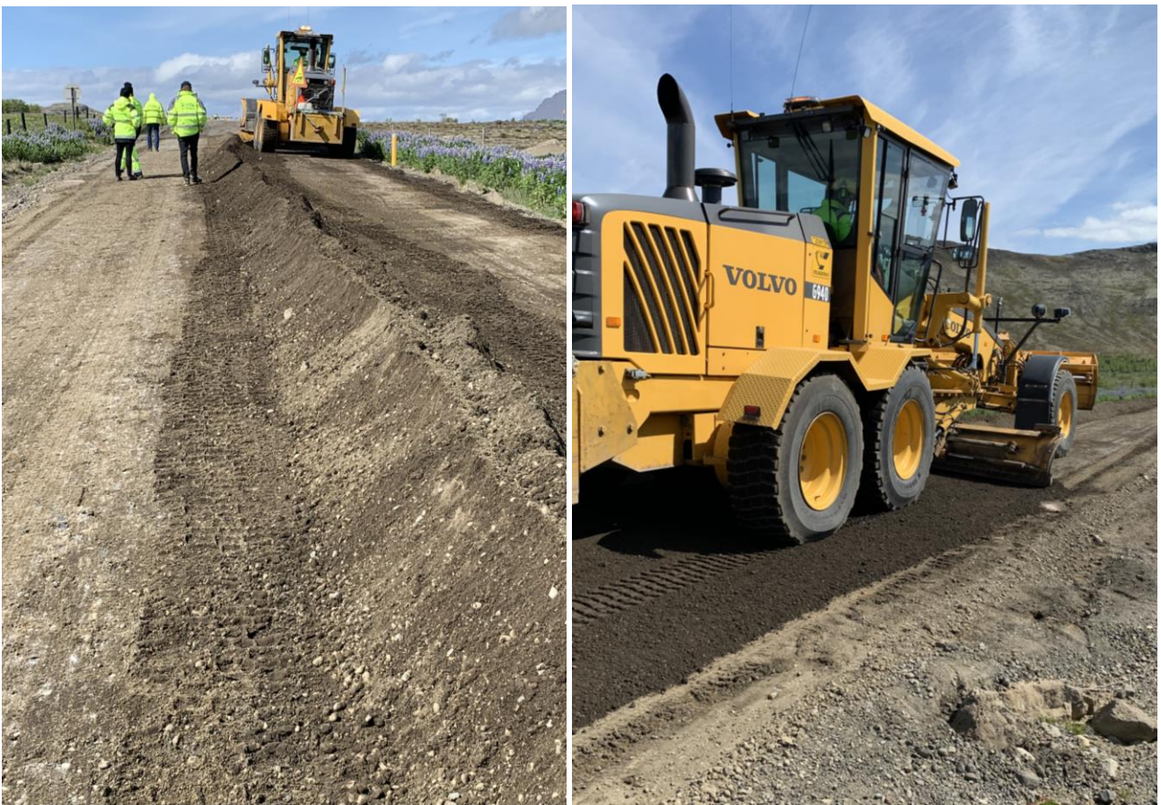
Mynd 3: Framkvæmd tilraunar á Hafravatni. Til vinstri má sjá heflun á veginum og til hægri má sjá dreifingu á malar og bikþeytu blöndunni.
