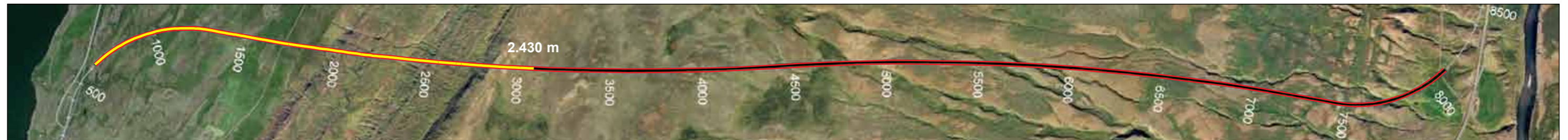
Vaðlaheiðargöng, staða framkvæmda 2. júní 2014. Büið er að sprengja 2.430 m frá Eyjafirði sem er 33,9% af heildarlengd.
