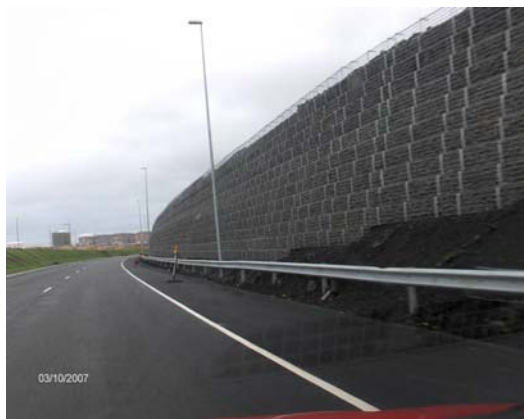
Mynd 10: Bitavegrið (W-vegrið) við Reykjanesbraut í Garðabæ.
