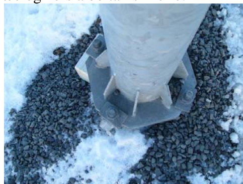
Mynd 18: Frágangur bolta, flansar og stýribox, íslensk útfærsla.
