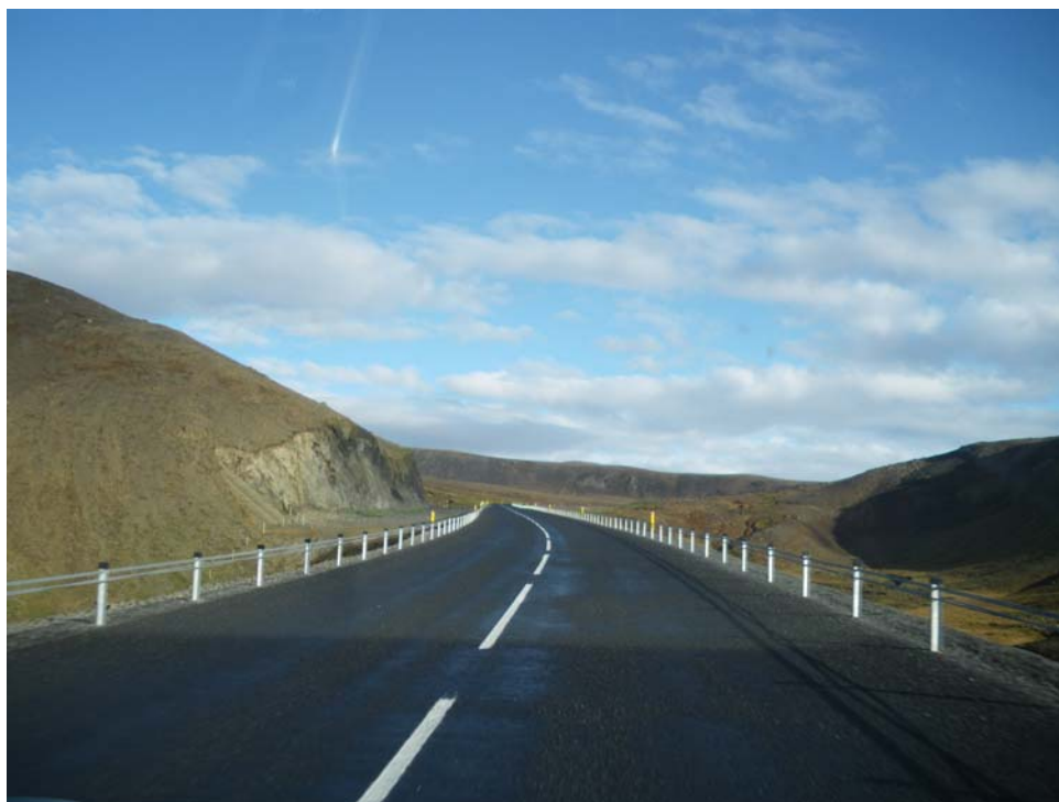
Mynd 4: Víravegrið á Hófaskarðsleið. 29
