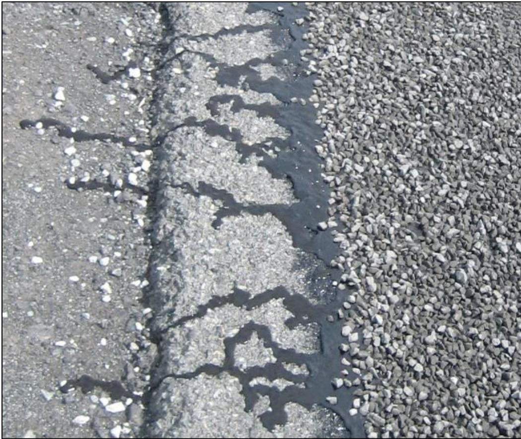
Mynd 1 Leki á bikþeytu út í kantinn áður en steinefni var lagt
