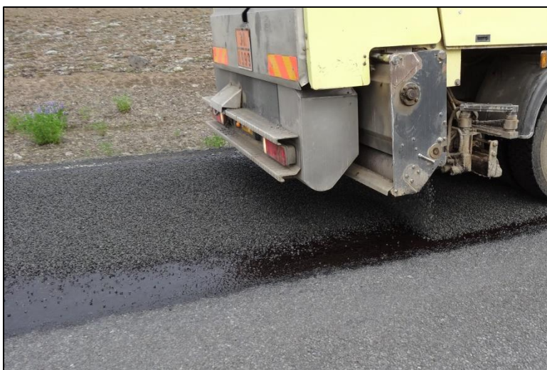
Mynd 4 Steinefni vantar næst saum þar sem bæta þurfti við steinefni
