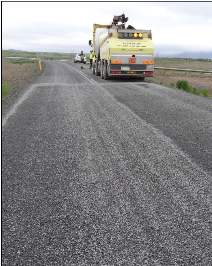
Mynd 3 Unnið að lögn tilraunakafla með bikþeytu á Nesjavallavegi með blettabíl
